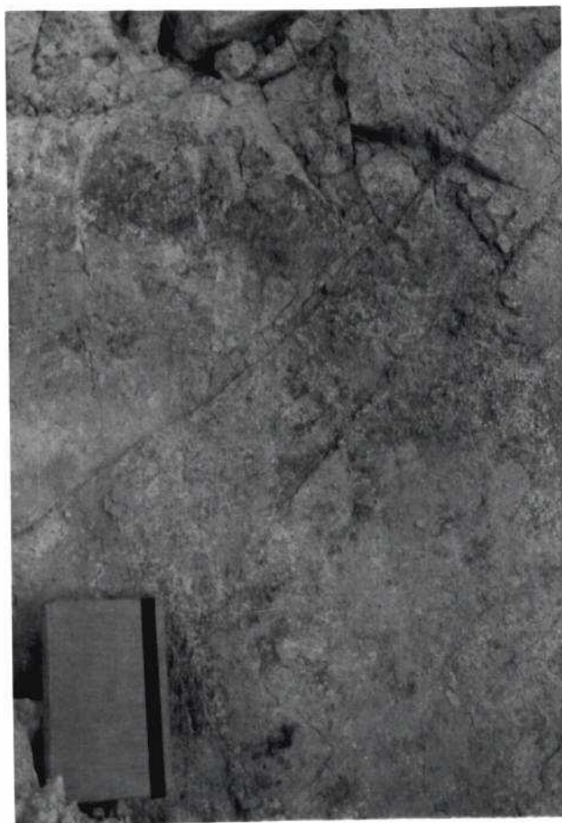
FOTOGRAFIA Nº 29 DISCONTINUIDAD CON MOVIMIENTO LATERAL
