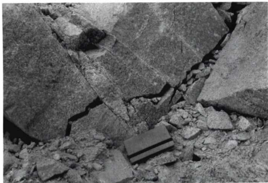
FOTOGRAFIA Nº 22 CRUCE DE DISCONTINUIDADES
