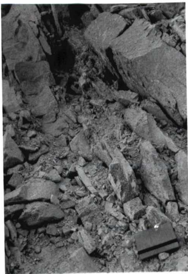
FOTOGRAFIA N o 18 RELLENO LAJOSO EN DISCONTINUIDAD
