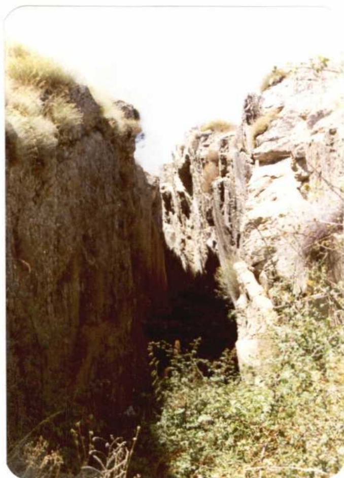
Fotografía nº 3 Detalle de paredes de dique.
