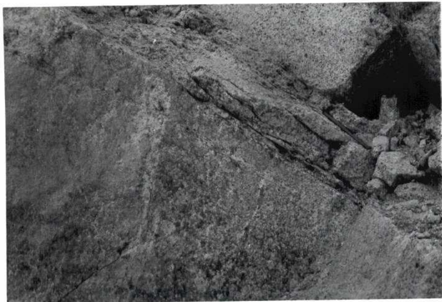
FOTOGRAFIA Nº 17 RELLENO LAJOSO EN DISCONTINUIDAD
